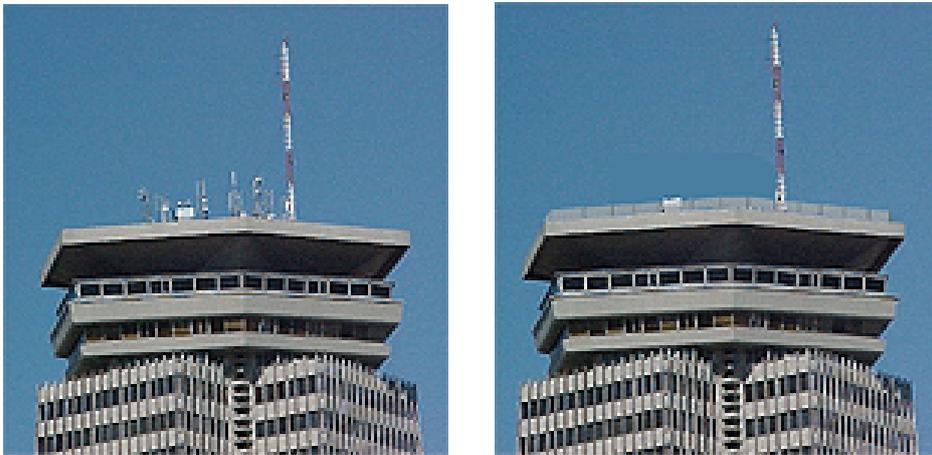
**Figura 7.- Ejemplo de mimetización de antenas (Fuente: Tradia).**
